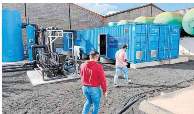
Nueva desaladora portátil en Punta de Los Vientos, para producir agua de uso agrícola. COBER LANZAROTE
